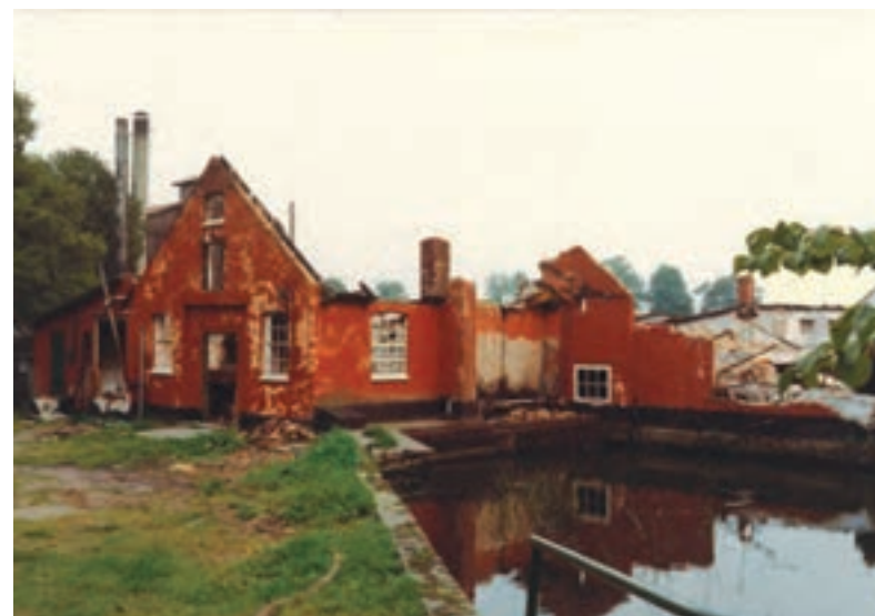
Turbinehuset efter branden
