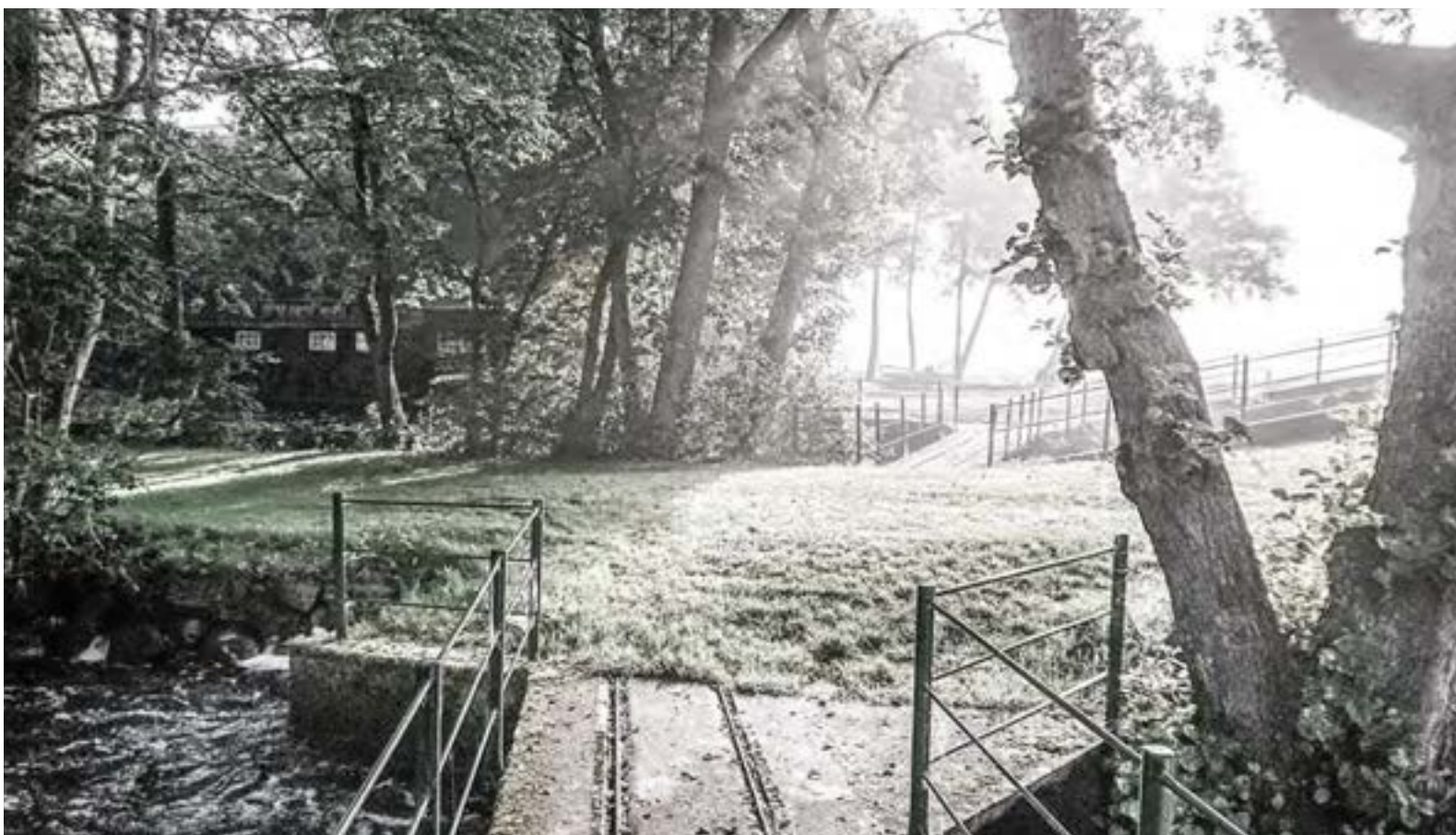
SMALLE TIPVOGNSSPOR SLANGER SIG GENNEM LANDSKABET MELLEM FABRIKKENS BYGNINGER OG HUSE. MANGE STEDER DÆKKET TIL AF JORD OG MURBROKKER EFTER BRANDEN I '74.
