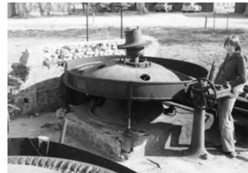
Blotlagt turbine efter branden
